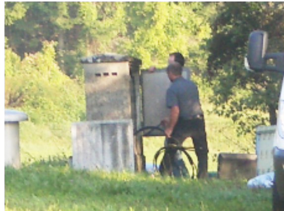
Installationsarbeiten am 26. September 2011
